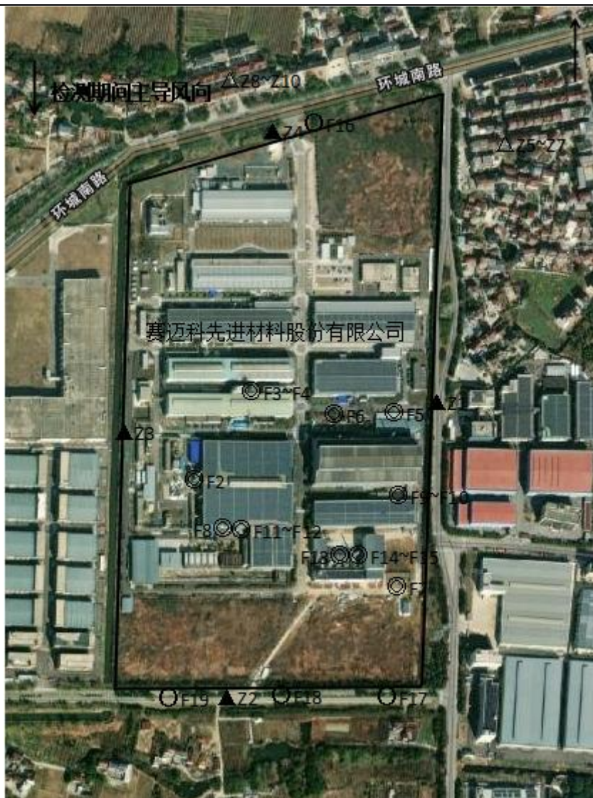
○-无组织废气采样点，◎-有组织废气采样点
