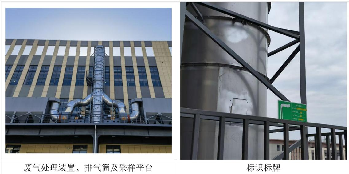
图 3-4 废气处理措施照片示例
