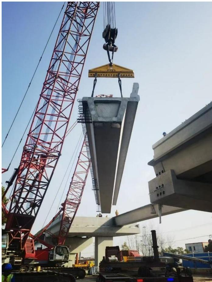
图 2-9 小箱梁吊装示意图
