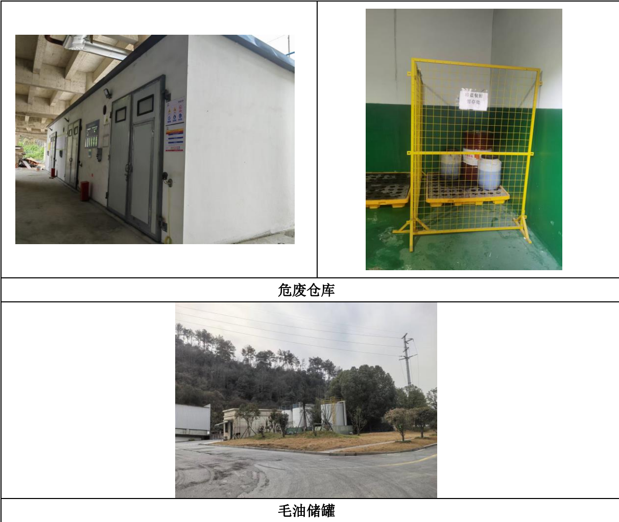
图4-5 固废暂存设施照片
