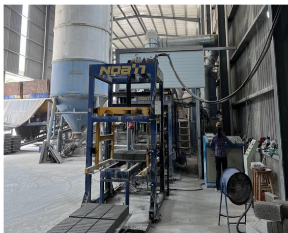
再生砖制砖生产线
